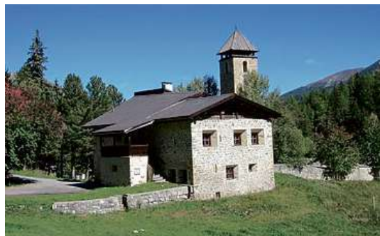
Die Bündner Regierung unterstützt die Sanierung des Ospiz Chapella . (ZVG)
