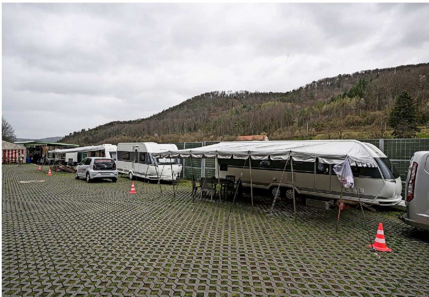
Der Holchen präsentiert sich heute aufgeräumt, mit Lärmschutzwand und allen notwendigen Anschlüssen. Foto: Dominik Plüss
